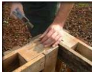
3 - Com a ajuda de um martelo, unir cuidadosamente as duas palletes com pregos.
