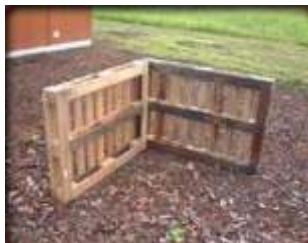
2 - Juntar a segunda pallete num dos cantos da primeira
