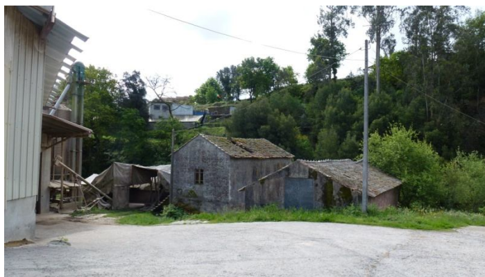
Ilustração 7– Arruamento junto a indústria, sem saída, sem qualquer ordenamento e em mau estado de conservação
