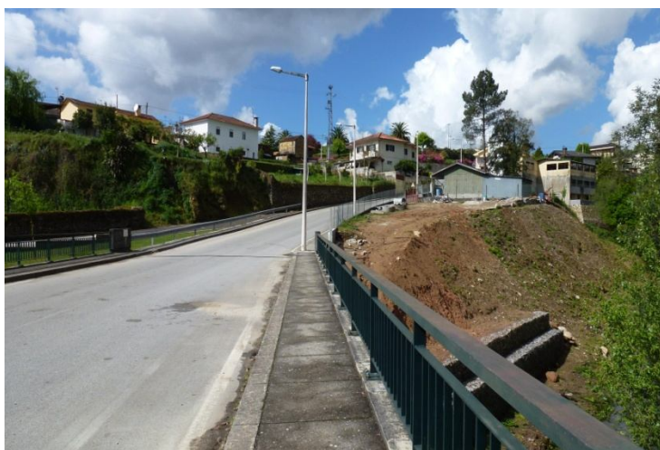
Ilustração 6– Arruamento principal de acesso desde a EN 1 com perfil irregular e passeios estreitos
